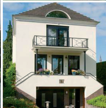
versieringen in de gevel
